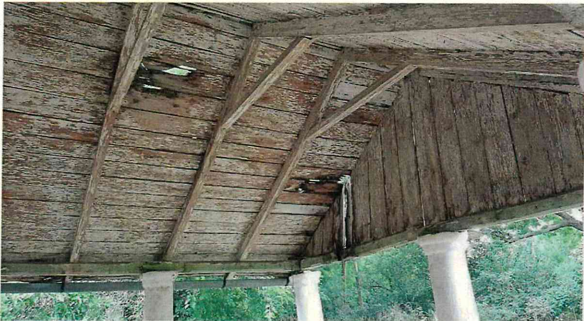
A pillérek feletti fa tetőszerkezet leromlott állapotú, cseréje szükséges
