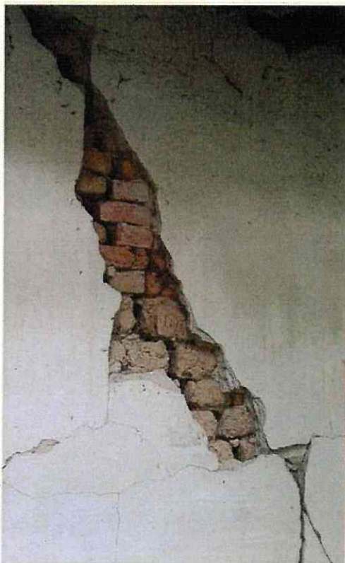
Jelentős mértékű nyílás a falon, téglakötés szabályainak be nem tartásának következménye
